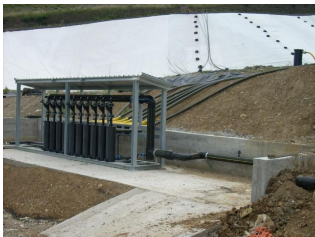
Figura 9-1 – Stazione di regolazione
