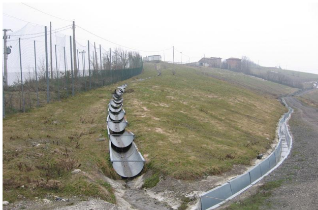
Figura 9-2 - Canalette di raccolta delle acque meteoriche
