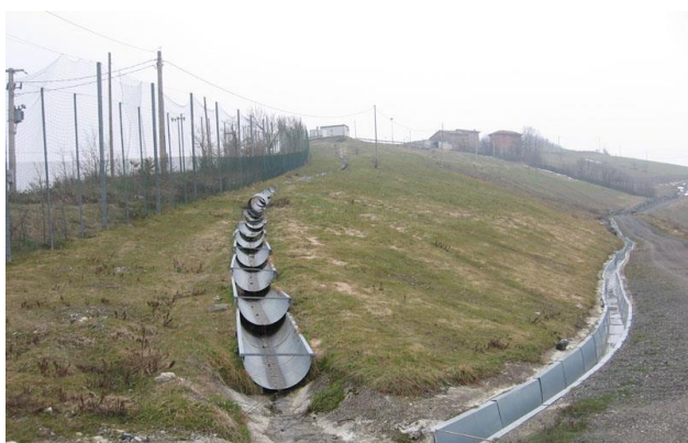
Figura 9-2 - Canalette di raccolta delle acque meteoriche
