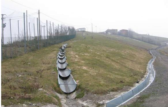
Figura 9-2 - Canalette di raccolta delle acque meteoriche
