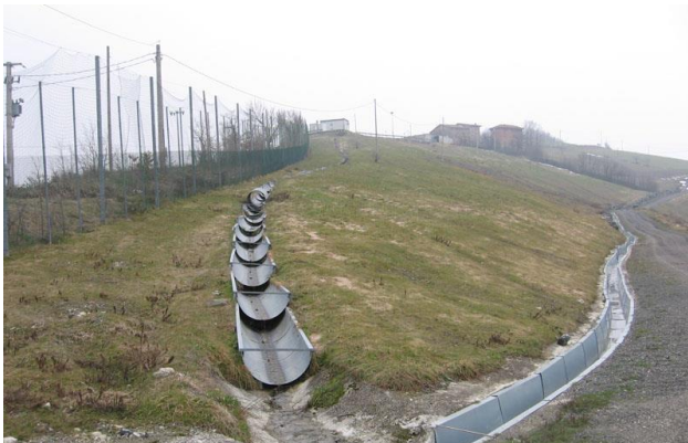
Figura 9-2 - Canalette di raccolta delle acque meteoriche
