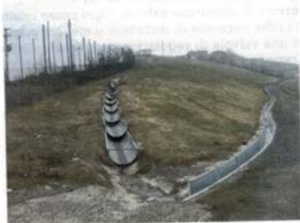
Figura 9-4 - Cagalette di raccolta delle acque meteoriche
