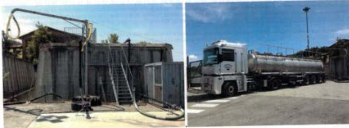
Figura 9-2 - Carico del percolato dalla vasca di stoccaggio nell'area servizi della discarica
