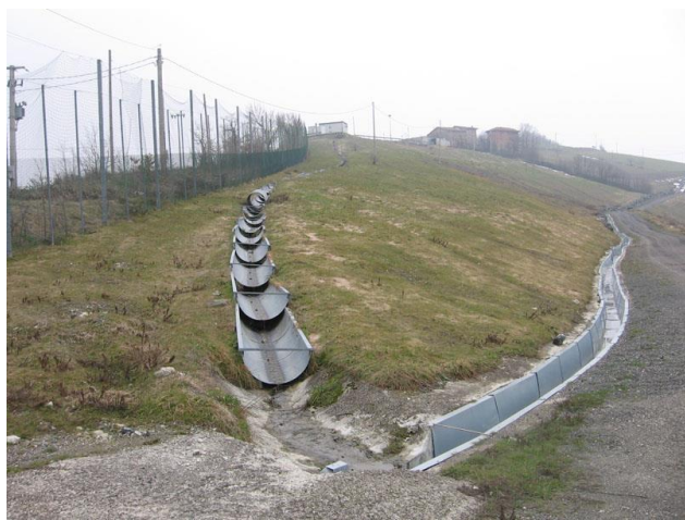
Figura 9-4 - Canalette di raccolta delle acque meteoriche
