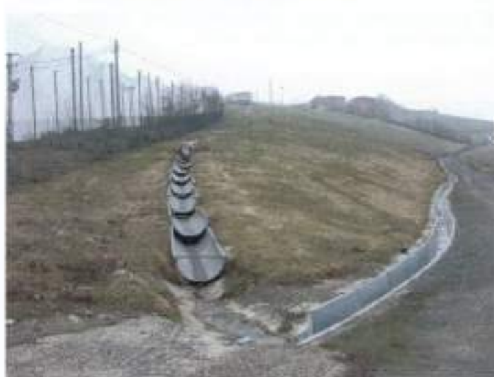
Figura 9-6 - Canalette di raccolta delle acque meteoriche
