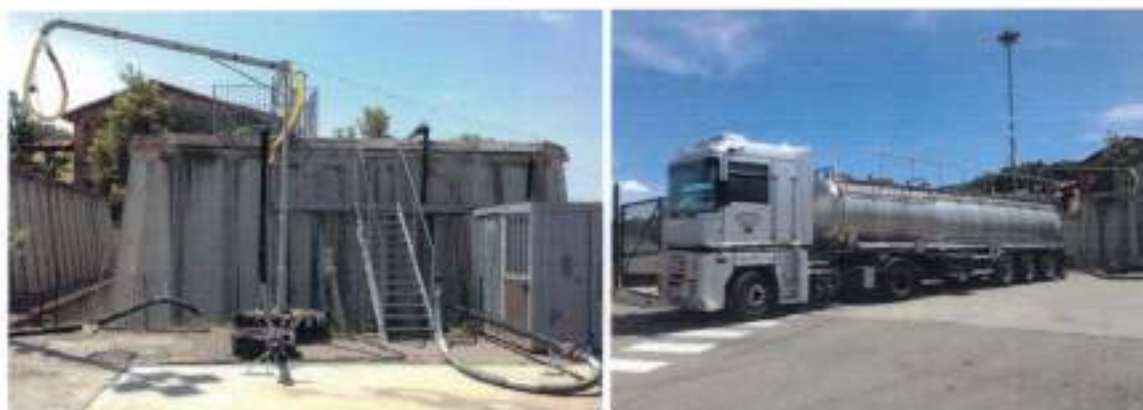
Figura 9-3 - Carico del percolato dalla vasca di stoccaggio nell'area servizi della discarica
